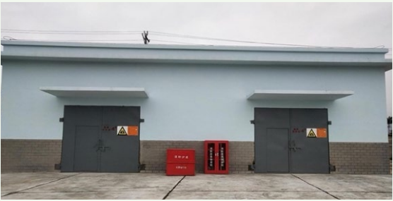
锡化工有机锡新建危废暂存库
