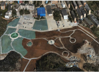
老厂分公司大明槽露天采场治理
