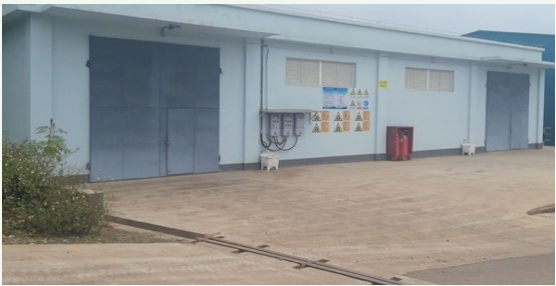
大屯锡矿新建危废暂存库
