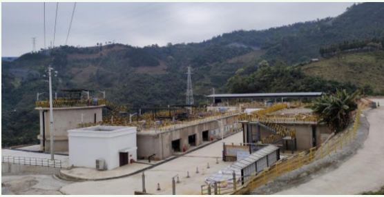
华联锌铟公司铜街大沟外排水深度治理项目
