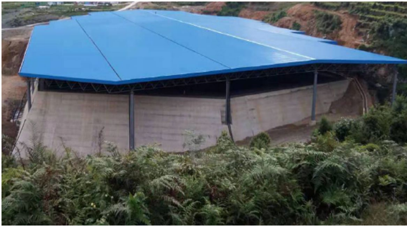
文山锌铟危险废物填埋场
