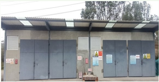
云锡机械公司新建危废暂存库
