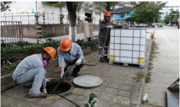
锡化工公司危险化学品泄漏事故演练
