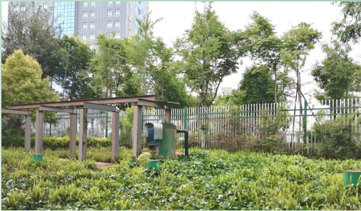
改造后的雨水池
