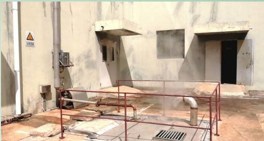
改造后的洗瓶水池
