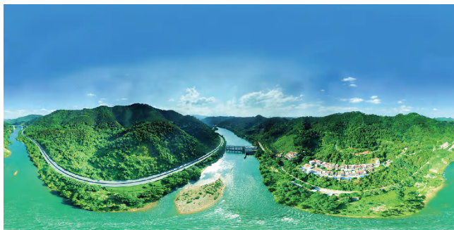
广西百色水利枢纽通航设施工程
