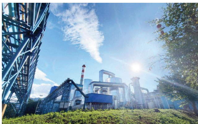
锡冶炼低浓度二氧化硫制酸烟气处理系统
