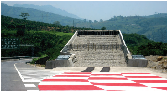
“山区高速公路运营保障关键技术及装备”项目围绕西部山区高速公路桥隧结构安全保障、高陡边坡稳定性保持和连续长大下坡路段安全运行性能提升等方面的技术难题，通过产学研联合攻关，历时 10 余年，攻克了高墩大跨混凝土桥梁缺损状况监测评定、隧道安全可靠移动快速无损检测诊断、高陡边坡稳定性甄别与保持和连续长大下坡安全保障等方面的关键技术，其成果在云南、重庆、浙江等省市 78 条山区高速公路上成功应用，累计应用里程达 6240 公里，研制的装备应用于 1054 余个路段，产生直接经济效益 53.4 亿元。图为网索避险车道。
