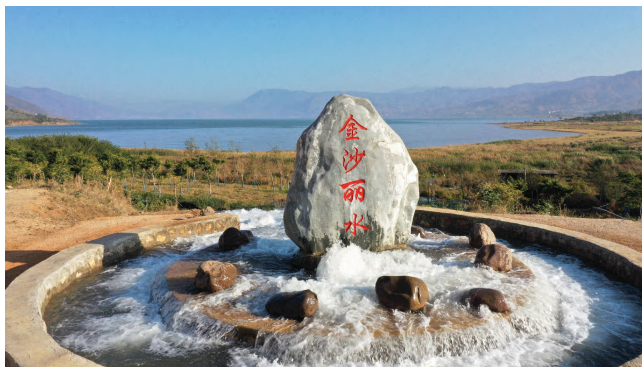
程海骨干引水出水口
