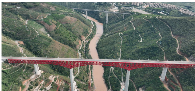
中老铁路元江特大桥
