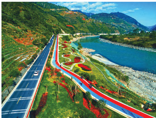
建设美丽公路
