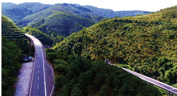
小磨公路位于西双版纳热带雨林区域，工程建设与环保压力巨大，项目遵循环保选线，减少开挖，增加桥隧比，最大限度保护生态
