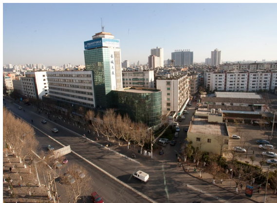
回迁安置房改造前
