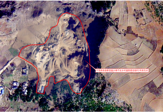
丽江矿山修复项目
