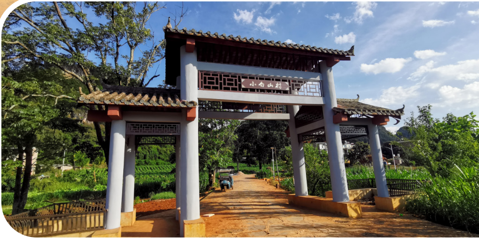
人居环境整治小白山村小组入村道路硬化
