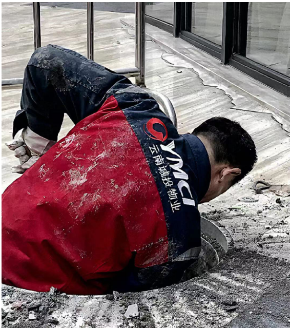
成都融城云熙项目，工程维修人员正在抢修停车场出口处的井盖，保障出行车辆和人员安全
