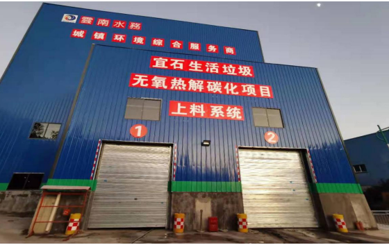
宜石生活垃圾无氧热解碳化项目
