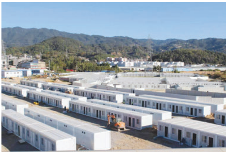
临翔区疫情防控集中隔离点箱体安装
