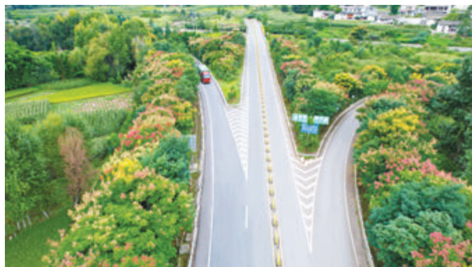
昭会高速超车立交绿美公路工程
