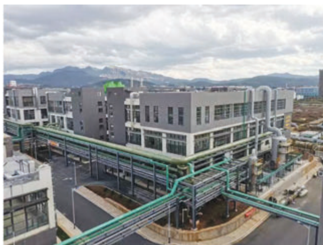
正在建设中的贵金属前驱体产业化项目
