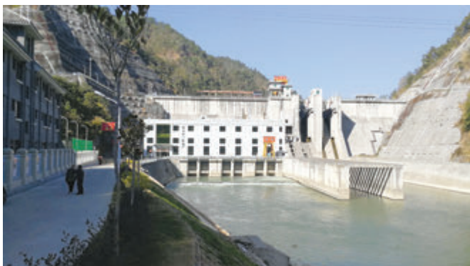
绿色电力助力地方经济发展：装机容量 9.5 万千瓦的腾龙桥一级发电厂
