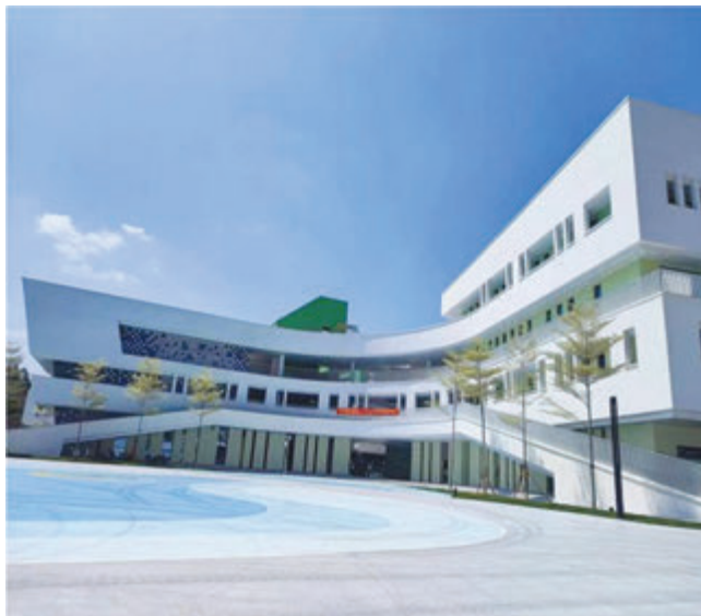
普洱市中心小学建设项目
