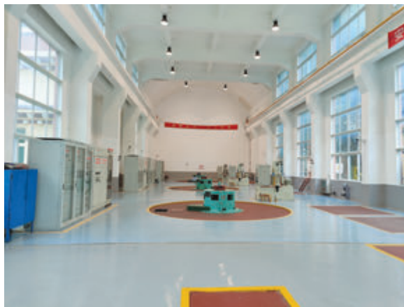
香格里拉市花椒坡水电站发电厂房
