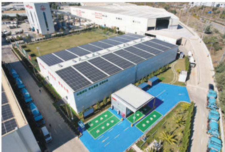
昆明经开绿色生产基地光伏一期项目
