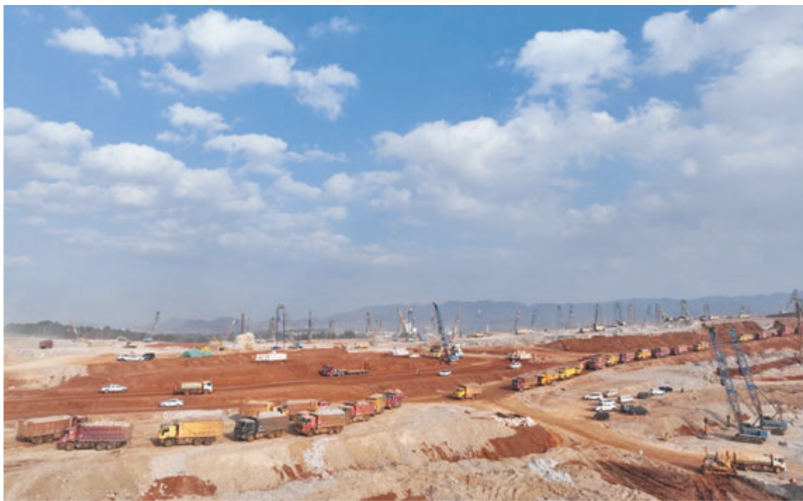
云南绿色低碳示范产业园（泸西）施工现场
