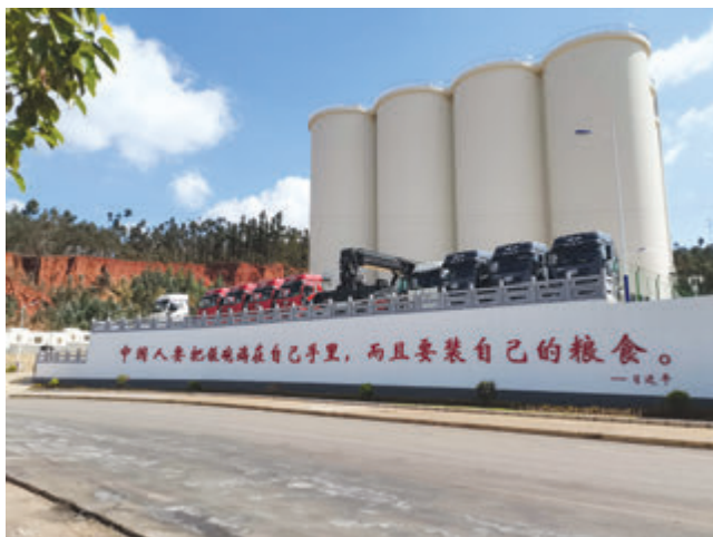
滇中（玉溪）粮食仓储中转库
