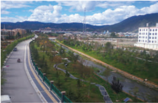
香格里拉县城市环境综合治理项目纳赤河支流治理后
