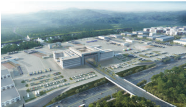
口岸作业区联检大楼
