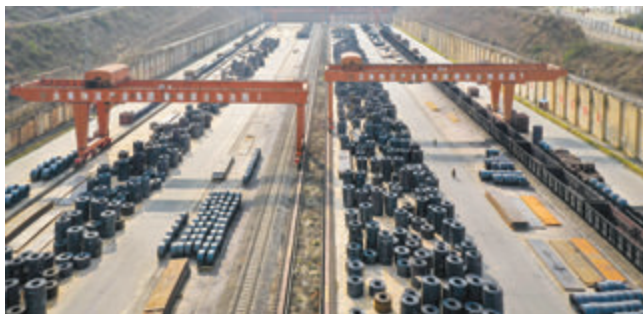
云南新钢综合物流园
