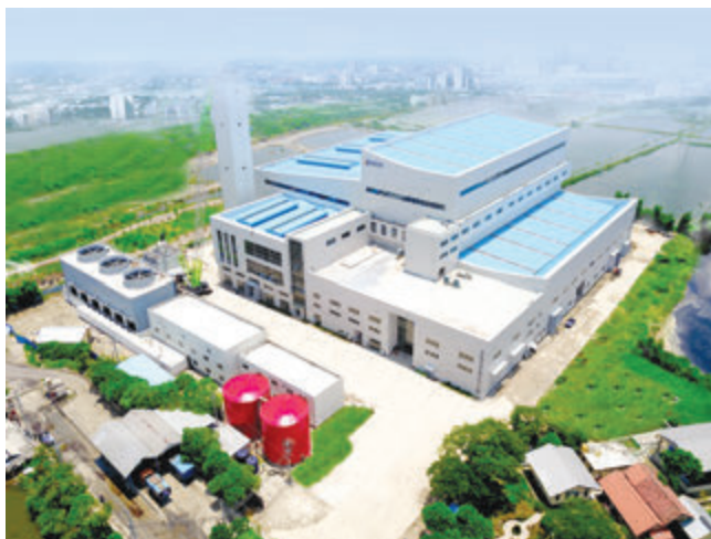
运营的印尼泗水在建垃圾热解气化发电项目全景
