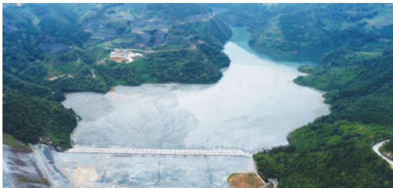
云锡在用的铜街大沟尾矿库
