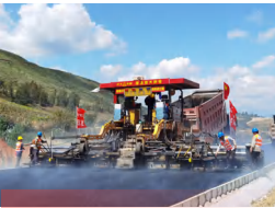
党旗在工地一线飘扬
