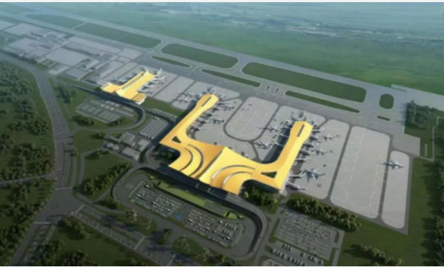
顺利推进西双版纳机场改扩建项目
