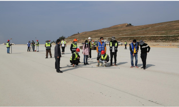
凤庆通用机场建设项目场道工程（道面水泥稳定碎石层）通过验收
