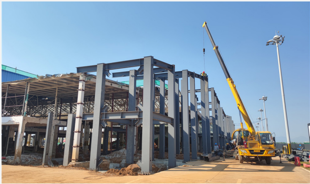
腾冲机场全力推进 T1 国际航站楼改造工程建设
