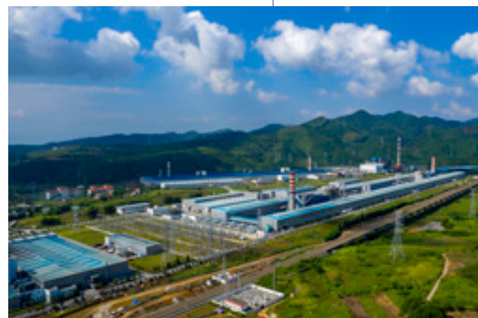
广西百矿集团新山铝产业示范园煤电铝一体化项目 (鲁班奖)
