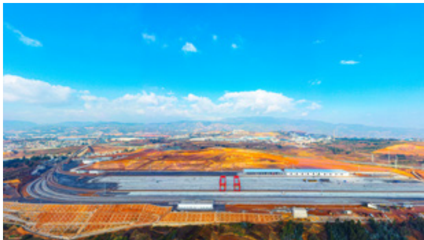
集团投资建设的云南省最大铁路专用线——祥云财富铁路专用线开通运营
