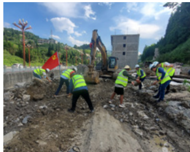
十公司为威信县安置点居民修缮道路
