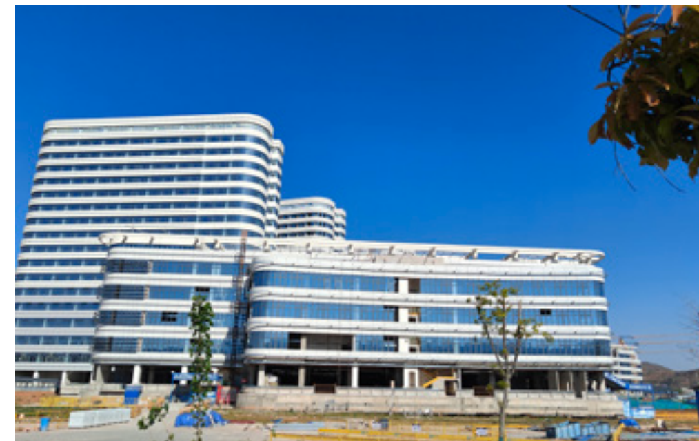
滇西区域医疗中心一期项目（云南省绿色施工示范工程）
