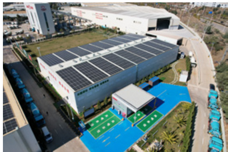
集团混凝土公司经开绿色生产基地光伏一期
