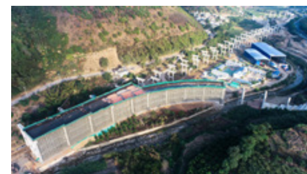
集团 PC 预制构件在永金高速投入使用
