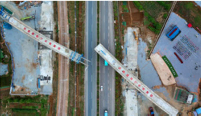
上跨广大铁路和楚大高速双 T 构转体施工
