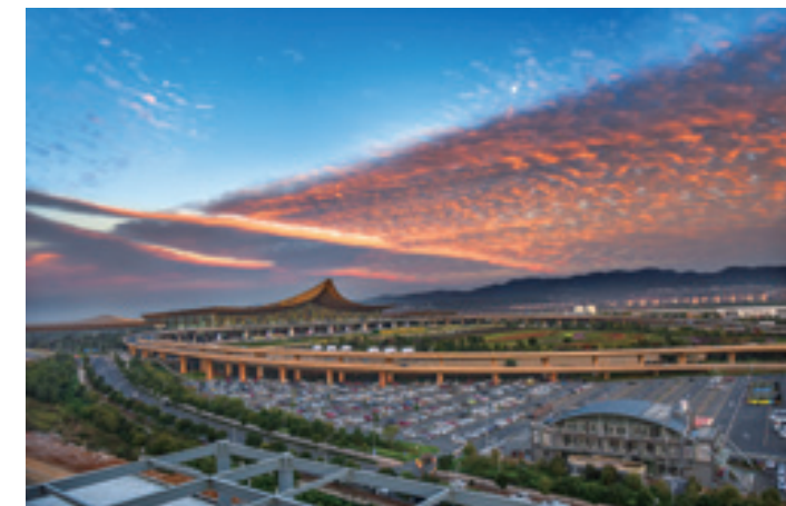
昆明长水国际机场 (鲁班奖、詹天佑奖)
