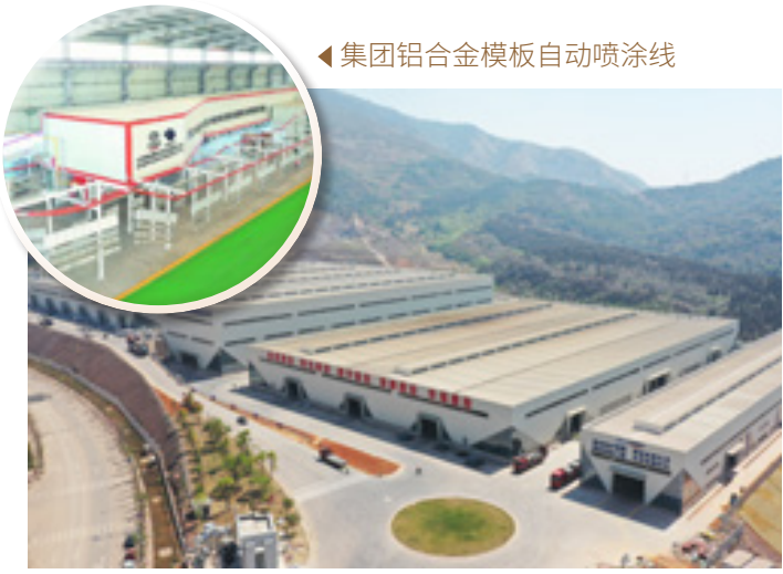
集团建筑铝合金模板智能制造产业园
