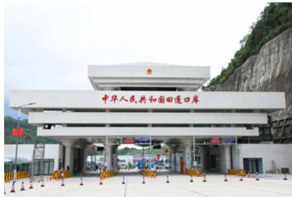
田蓬口岸建设项目
