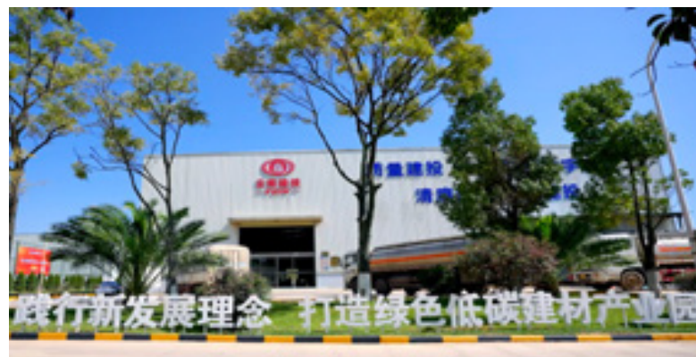
集团混凝土公司经开绿色生产基地
