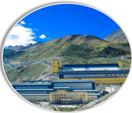
集团西藏巨龙铜矿项目
