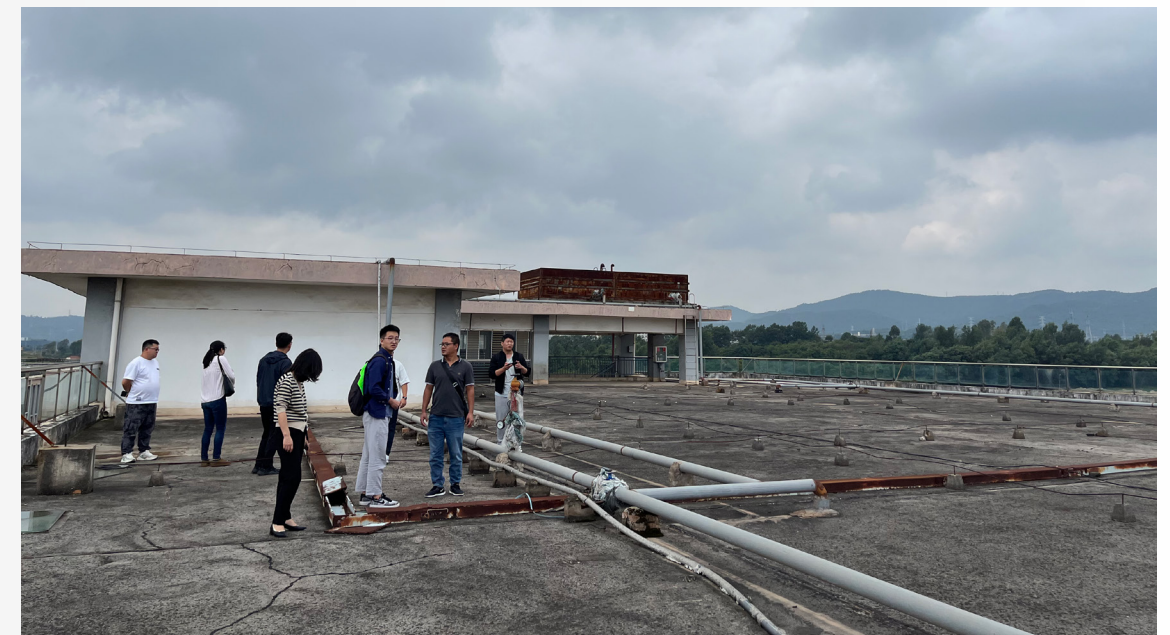
曲靖“人民公社”园区现场勘测
