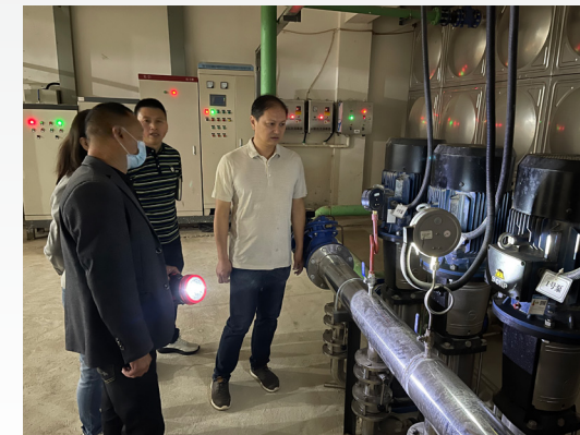
同图园区公司开展节前安全及维稳工作自检自查
