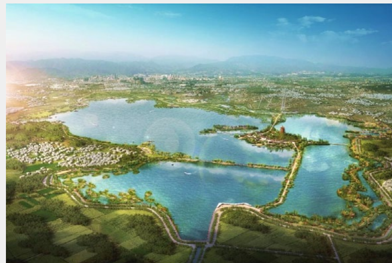
▲ 祥云县青海湖水环境综合治理工程
