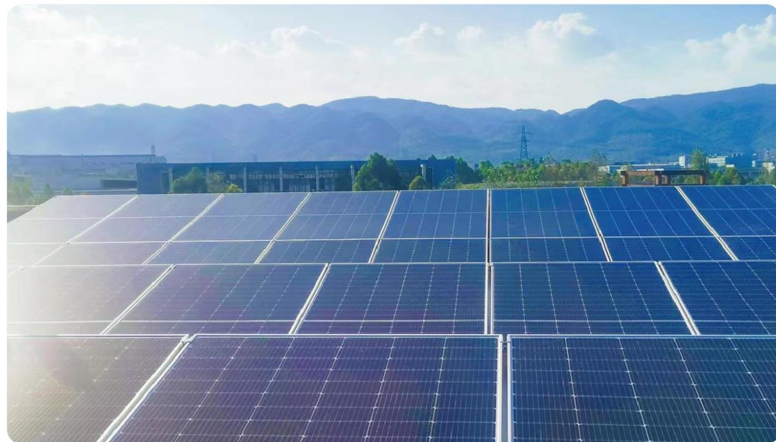
● 重庆亿焯负责的复合材料支架光伏发电示范工程——屋顶分布式光伏发电项目竣工
