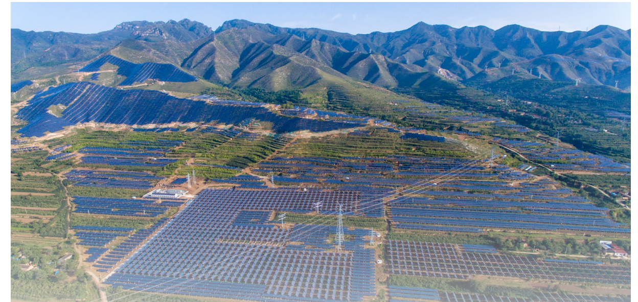
山西省运城市芮城协鑫光伏发电厂
